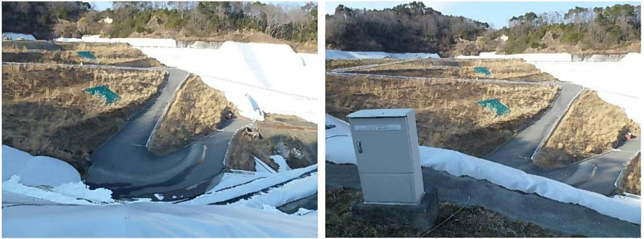
図2 2015年2月13日の現場測定状況（中継端子付近の天端部より埋立地を撮影）
